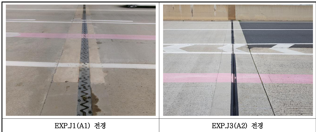
【사진 14.3.42】 신축이음장치 전경
