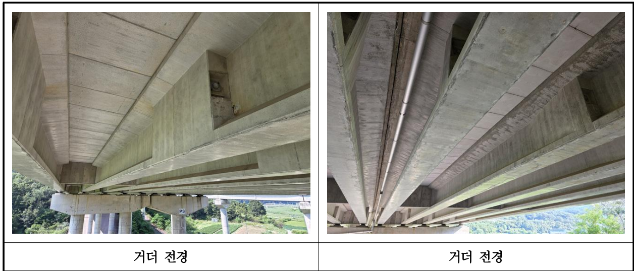
【사진 14.3.29】 거더 전경
