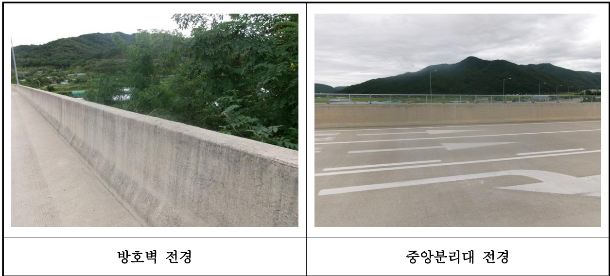
【사진 14.3.49】 방호벽 및 중양분리대 전경
