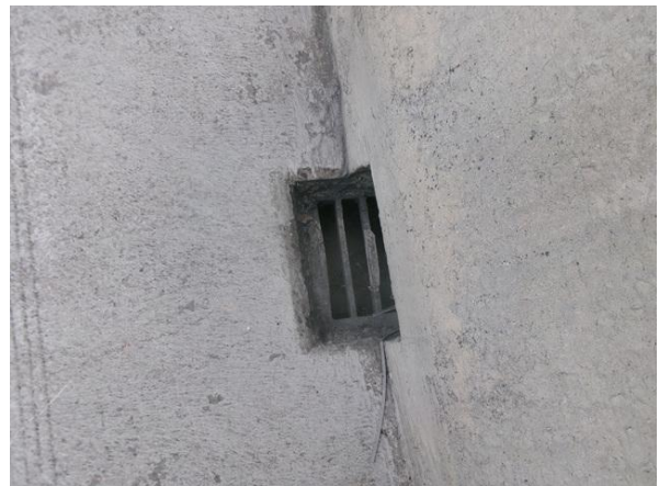
S4 교량 집수구 상태양호
