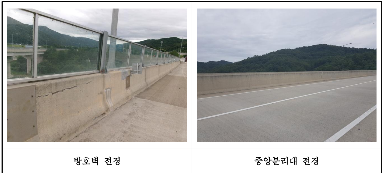
【사진 14.3.24】 방호벽 및 중앙분리대 전경
