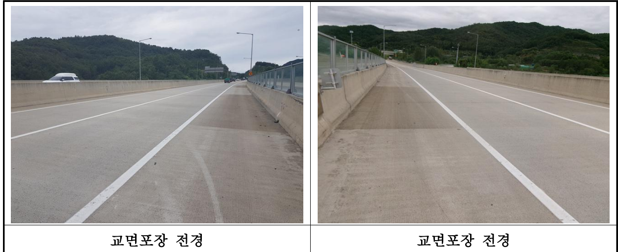
【사진 14.3.20】 교면포장 전경
