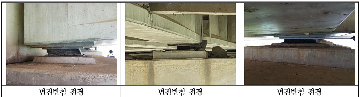
【사진 14.3.13】 교량받침 전경
