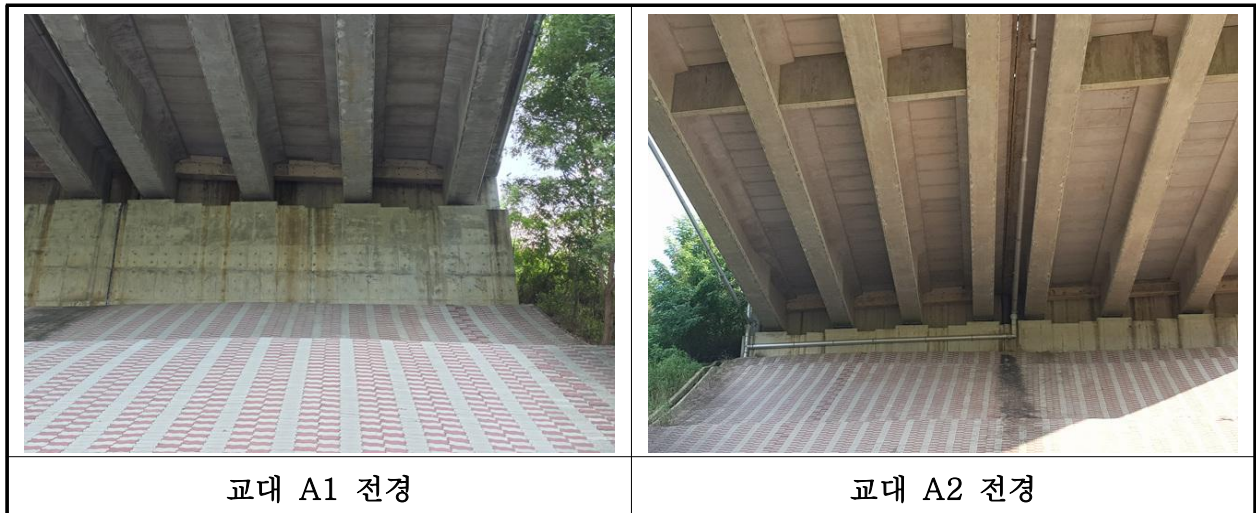
【사진 14.3.8】 교대 전경
