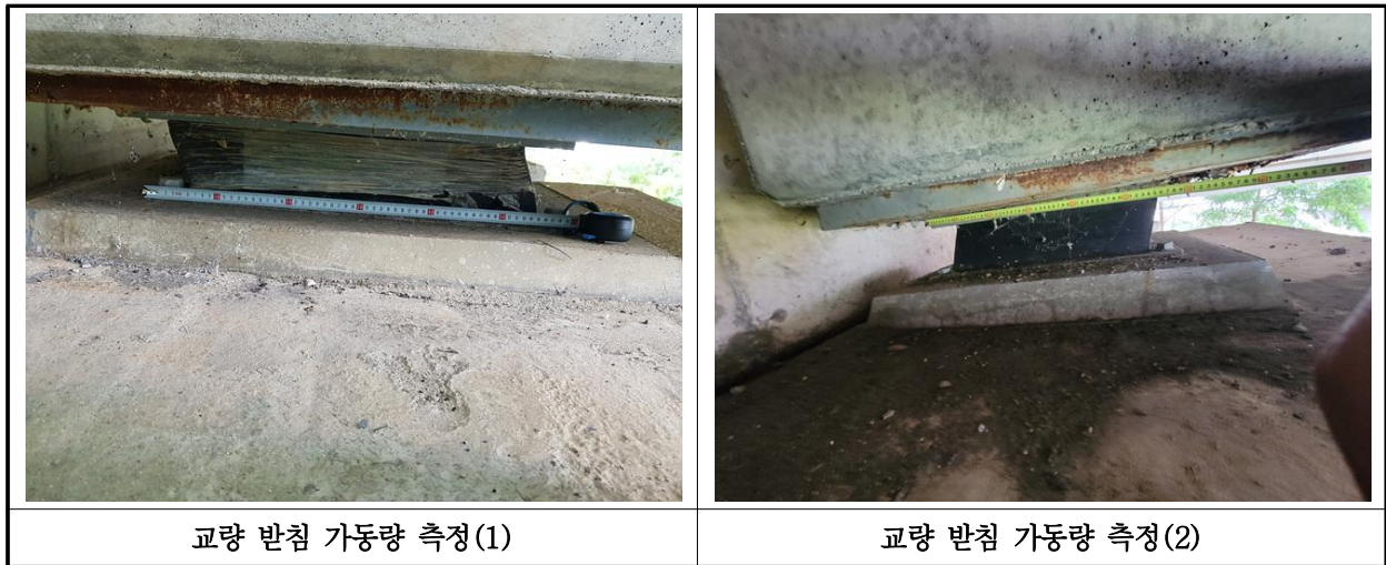
【사진 14.3.16】 교량받침 이동량 측정
