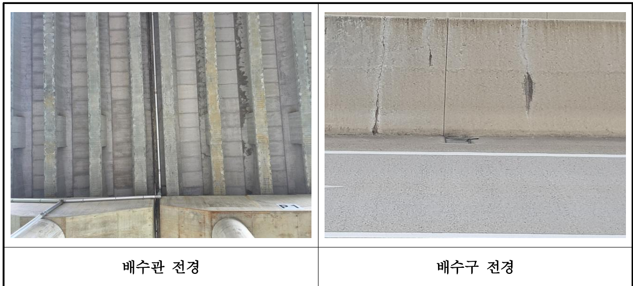
【사진 14.3.47】 배수시설 전경
