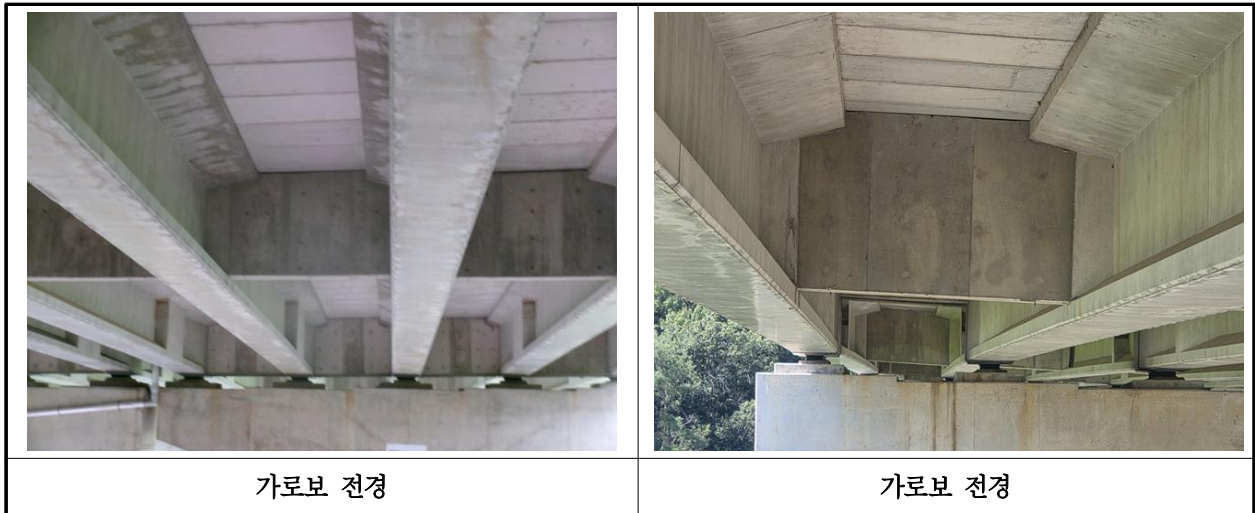
【사진 14.3.31】 가로보 전경
