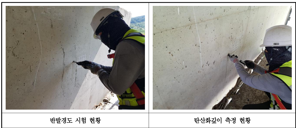
【사진 14.4.1】 콘크리트 내구성조사 현황
