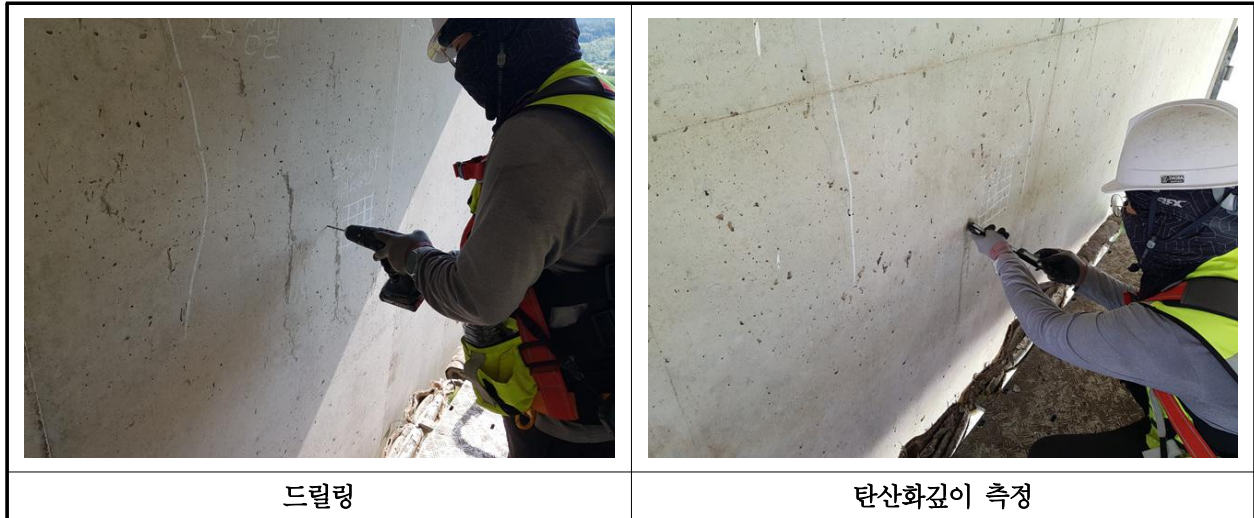
【사진 14.4.3】 탄산화 깊이 측정 현장사진
